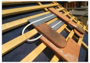
Die mit Solarflüssigkeit befüllte Verrohrung wird über an eine herkömmliche Solarpumpensteuerung angeschlossen und leitet die gewonnene Wärme in einen Solarbufferspeicher oder - wie in unserem Projekt – es wird über einen Wärmetauscher direkt das Hallenbadwasser beheizt.
